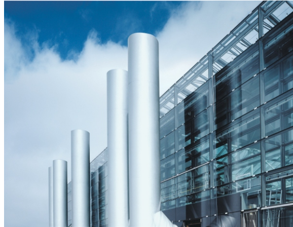
Lotnisko w Monachium, terminal 2, Kominy wywiewne i oddymiające
