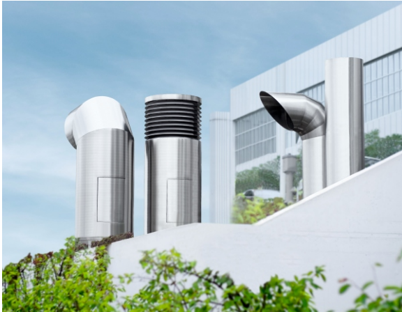
Wieże wentylacyjne BMW, Centrum Techniki i Innowacji, Monachium
